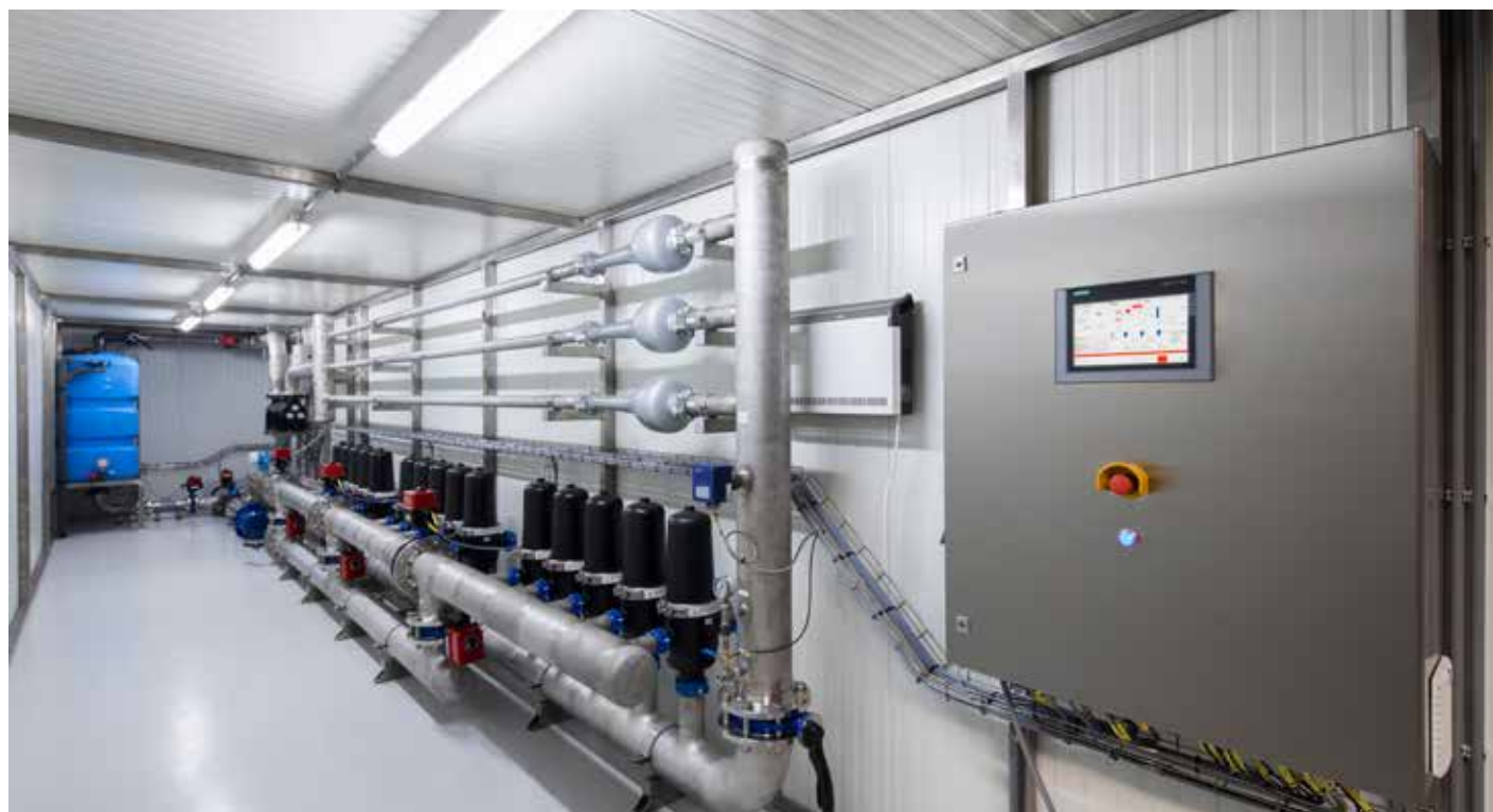
Chemievrije koelwaterbehandelingsinstallatie van Pathema om kalk, corrosie en microbiologische groei te voorkomen.
