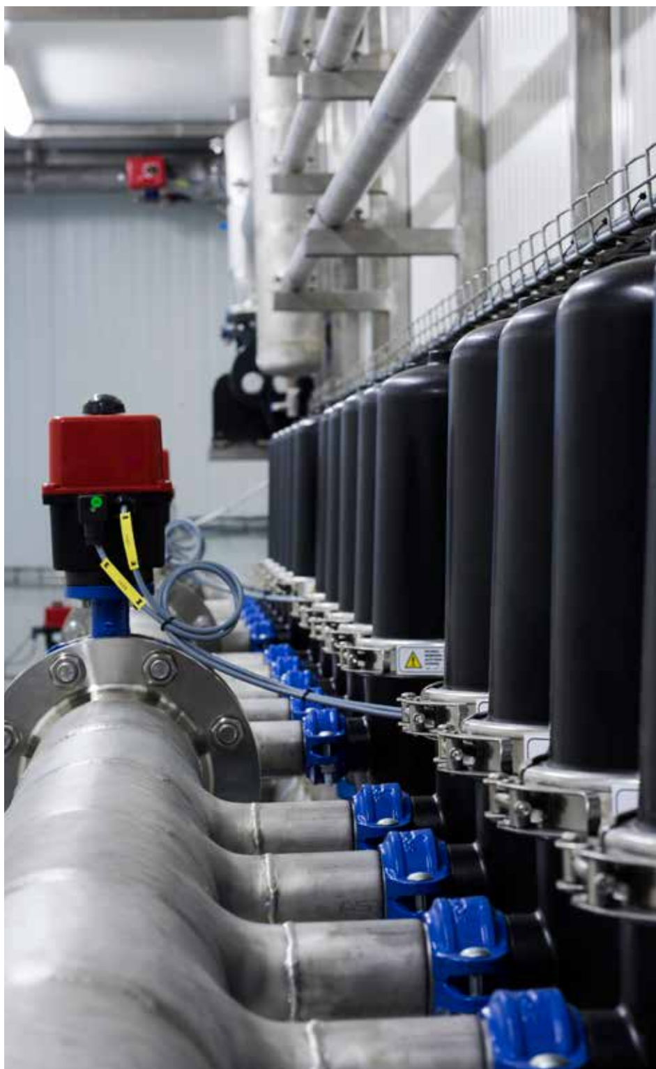
Disc filtratie om vaste deeltjes af te filteren en spuiwater daarna te kunnen hergebruiken.
